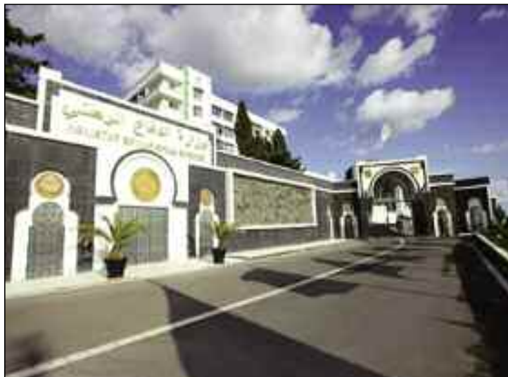
Poser les fondations de cette nouvelle République sous la bannière de la déclaration du 1er novembre. (Photo : D.R)
