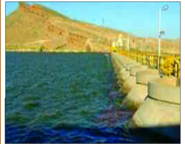
La réalisation du projet de construction du barrage Medjedel dans la wilaya de M'sila, d'une capacité de stockage de 15 millions m 3 , sera inscrite au titre de l'exercice 2021, a annoncé, jeudi à Alger, le ministre des Ressources en eau, Arezki Berraki.
