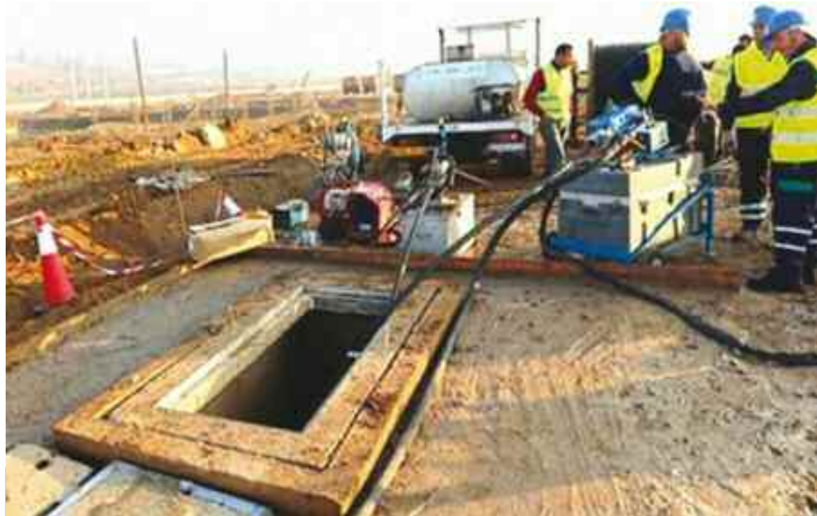
Quelque 2.261 accès au réseau de fibre optique FTTH ont été réalisés par Algérie Télécom (AT). (Photo : D.R)
