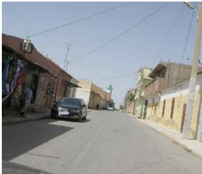
■ Le village de Zeguier connaît une dégradation avancée.
