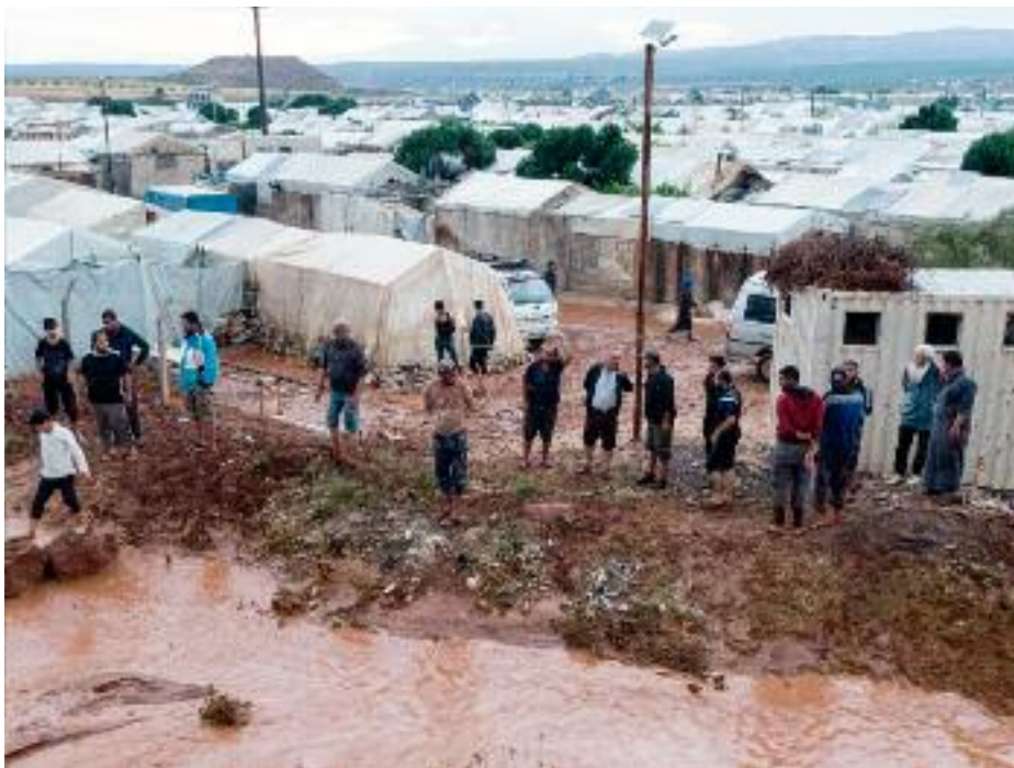
■ Camp de réfugiés de Deir Ballut en Syrie après des inondations.
